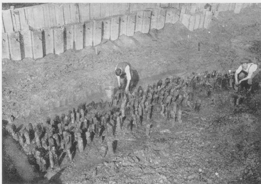
Taf. 11. 1. Hauptpalisade aufgedeckt.
