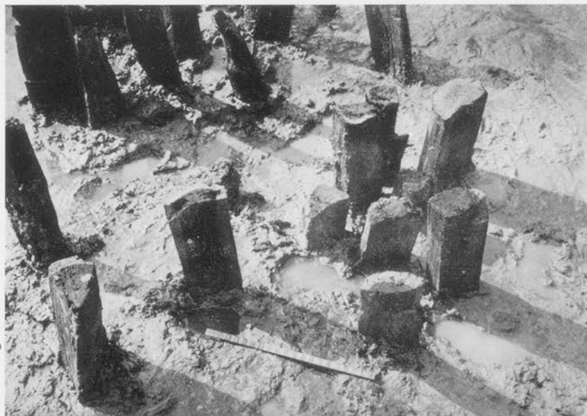
Taf. 13. 2. Tragpfähle. Haus 1 der älteren Siedlung. Nahansicht.
