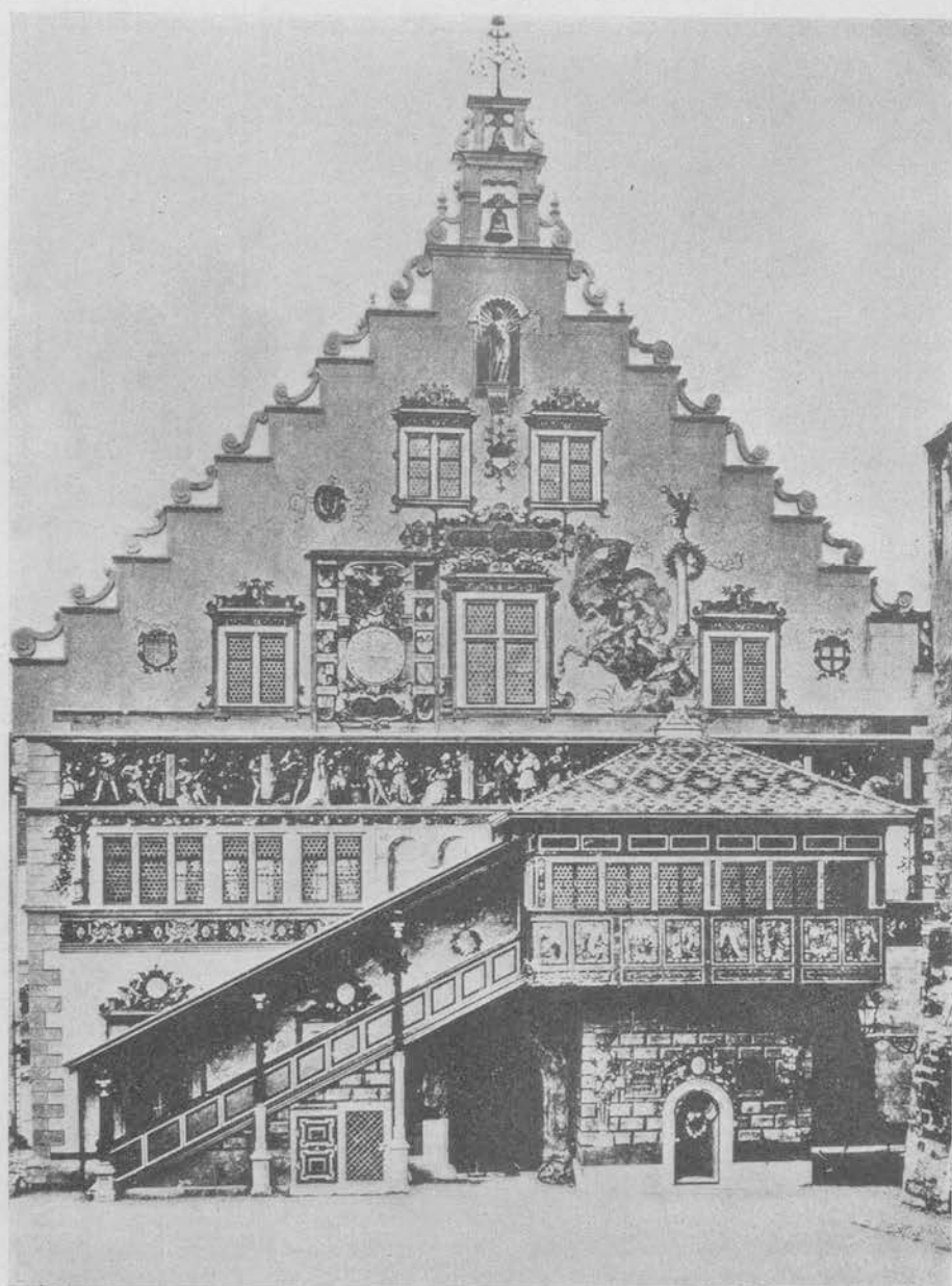
Das alte Lindauer Rathaus nach der Restaurierung.
