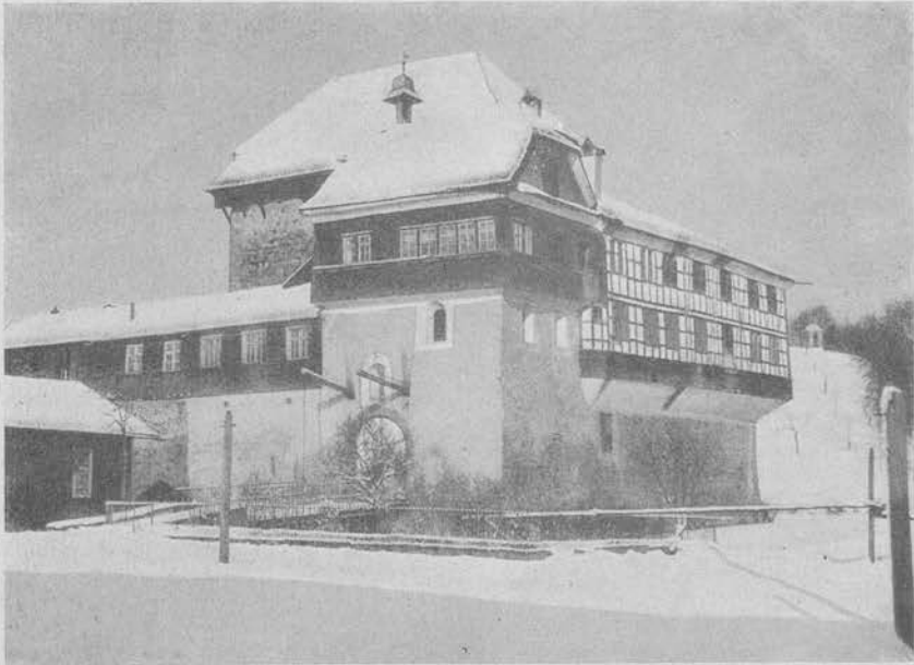
2. Schloß Hagenwil (Ränchlisberg) mit Zugbrücke und Wallgraben. Verwendung von erraticem Material als Baustein.
