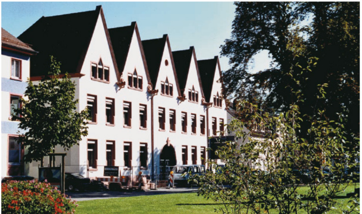
Abb. 4 Das im Stil der alten Fassade 2005 neu erstandene Gebäude der Landesversicherung Baden-Württemberg; künftig Deutsche Rentenversicherung Bund.
