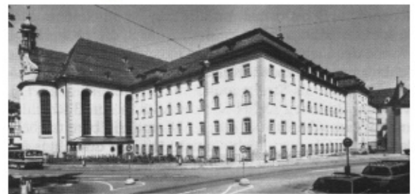
Südwestansicht der Klosteranlage. Im zweiten und dritten Obergeschoss befindet sich die Stiftsbibliothek.
