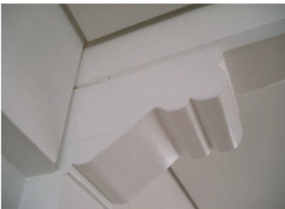
Die restaurierten Sattelhölzer
