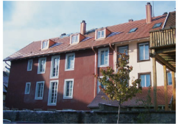
Blick von Rathausgasse
