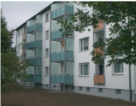
Neue Fassade mit Vollwärmeschutz.
