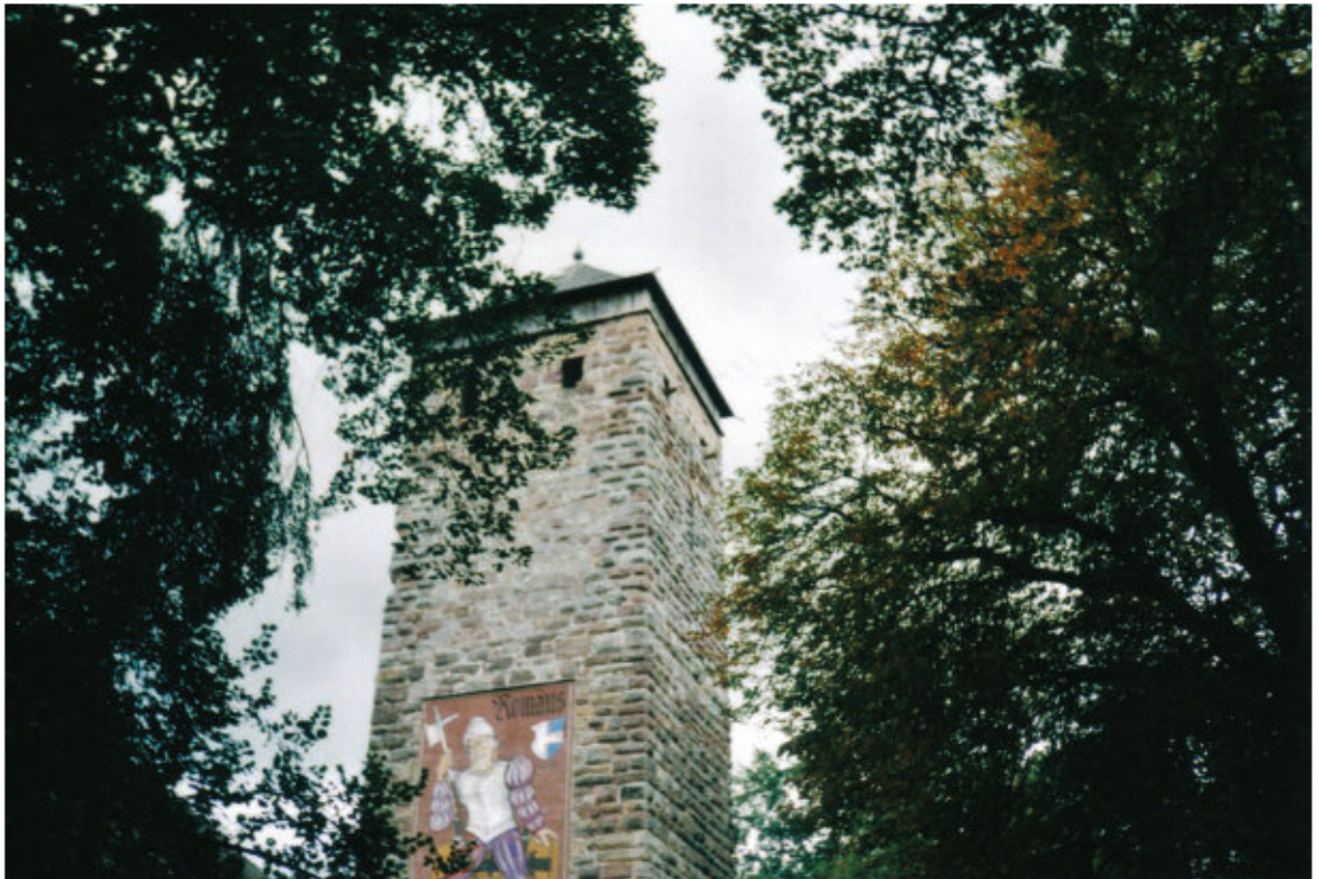
Blick auf den Romäusturm mit den auf das Hubenloch ausgerichteten Kanonen.
