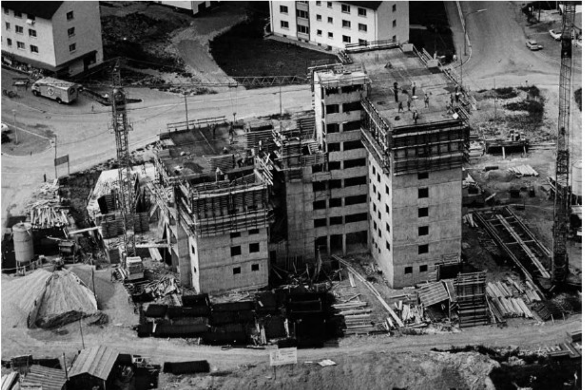
Baustelle Hochhaus am Berliner Platz aufgenommen 15. 6. 1963.
