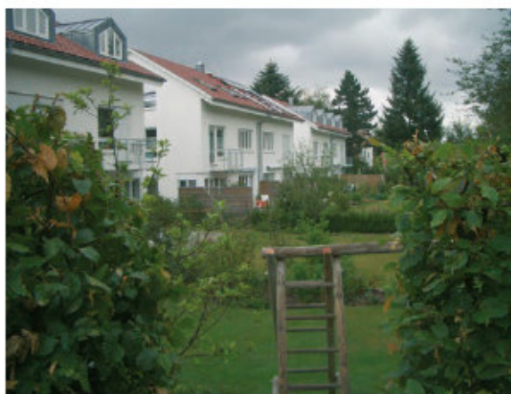
Doppelhäuser in der Keferstraße.
