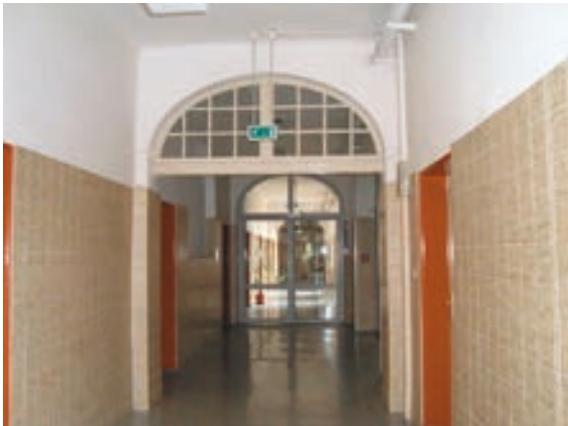
Abb. 10: Flurbereich vor dem Umbau.
