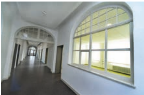
Abb. 11: Bestandsfenster im Flur im 1.OG.
