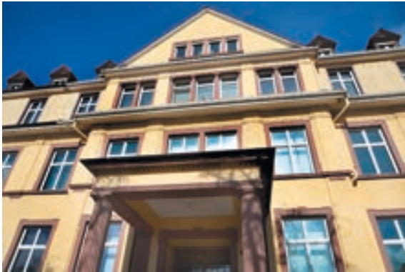
Abb. 6: Fassade von der Zugangsseite im Süden mit den neuen Fenstern.
