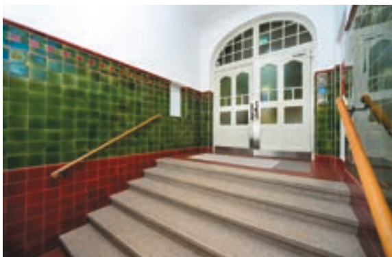
Abb. 15: Windfang nach der Sanierung.
