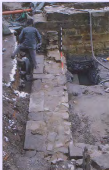
Abb. 18: Im Hintergrund die in den Stadtgraben gesetzte Mauer des Neuhauses, links das Auflager des Fallgatters, mit dem der Wasserweg in die Stadt gesperrt werden konnte (Landesamt für Denkmalpflege Baden-Württemberg im Regierungspräsidium Stuttgart, Arbeitsstelle Konstanz).
