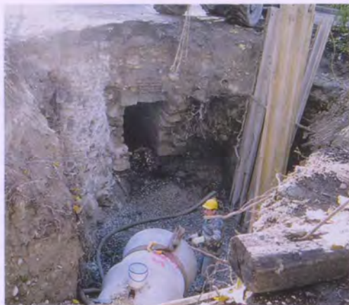
Abb. 12: Fundament der Ringmauer südlich des Paradieser Tores mit neuzeitlichem Abwasserkanal (Foto Entsorgungsbetriebe der Stadt Konstanz)
