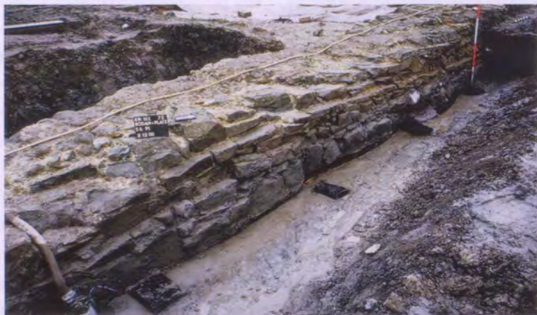
Abb. 27: Die Stadtmauer ruhte auf der Seeseite ebenfalls auf einem System aus mauerparallelen und rechtwinklig dazu gelegten Hölzern (Landesamt für Denkmalpflege Baden-Württemberg im Regierungspräsidium Stuttgart, Arbeitsstelle Konstanz, Foto: D. Bibby).
