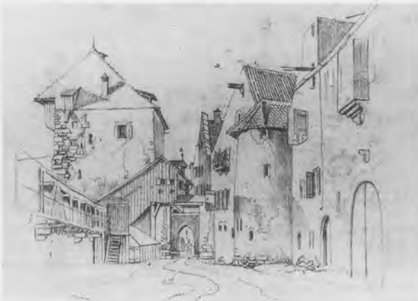
Abb. 11: Stadtmauern im Westen der Altstadt: Ältere Stadtmauer mit Turm (Häuserzeile rechts) und äußere Ringmauer mit Wehrgang und Paradieser Torturm. Heute verläuft hier die Obere Laube, Ecke Paradiesstraße (Klein 1819, Rosgartenmuseum Konstanz Inv. Nr. T 393).
