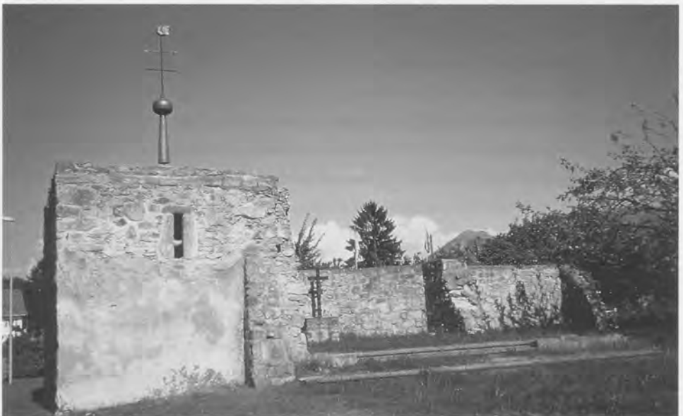
Abb. 7: Mauerreste der einstigen Jakobskirche im st. gallischen Grenzdorf Widnau (Foto: H. Tiefenthaler)
