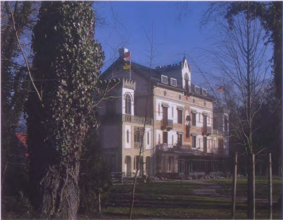
Abb. 3: Ansicht von Nordwesten
