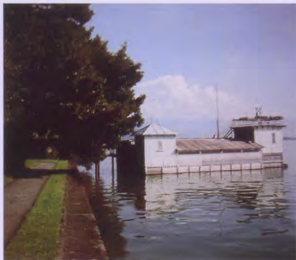
Abb. 25: ehemaliges Boots- und Badehaus, abgerissen
