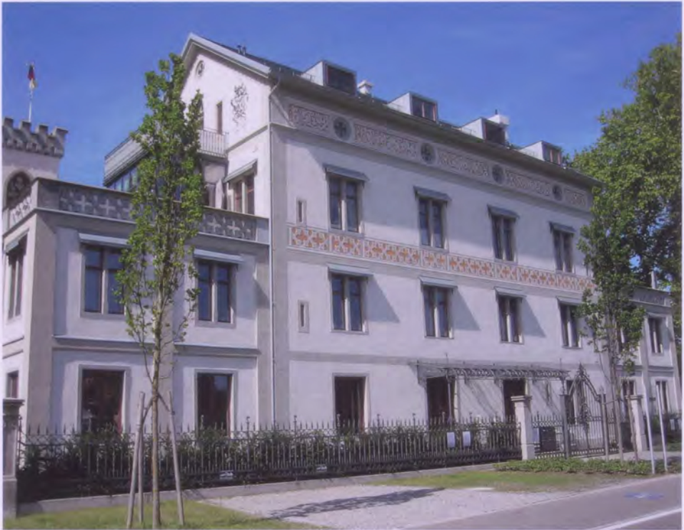
Abb. 2: Ansicht von der Straße nach der Sanierung
