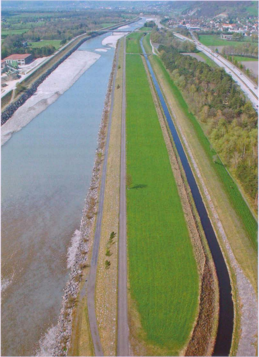
Abb. 2 Strukturdefizite der Fließgewässer: kanalisierter Alpenrhein mit Saar-Kanal (rechts) vor Trübbach b. Sargans (Foto: P. Rey, HYDRA Konstanz, März 2003)
