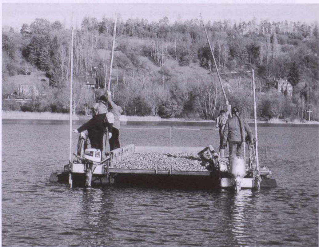
Abb. 5 Erosionsschutz bei freigelegten jungsteinzeitlichen und bronzzeitlichen Kulturschichten in der Flachwasserzone des Bodensees: (a) Taucher bei der Kontrolle der ausgelegten Geotextilmatten, (b) speziell konstruierte Klappschute zum zielgenauen Aufbringen der Kiesschüttung (Fotos: J. Königer, terramare – Archäologische Dienstleistungen, Freiburg i.Br.)
