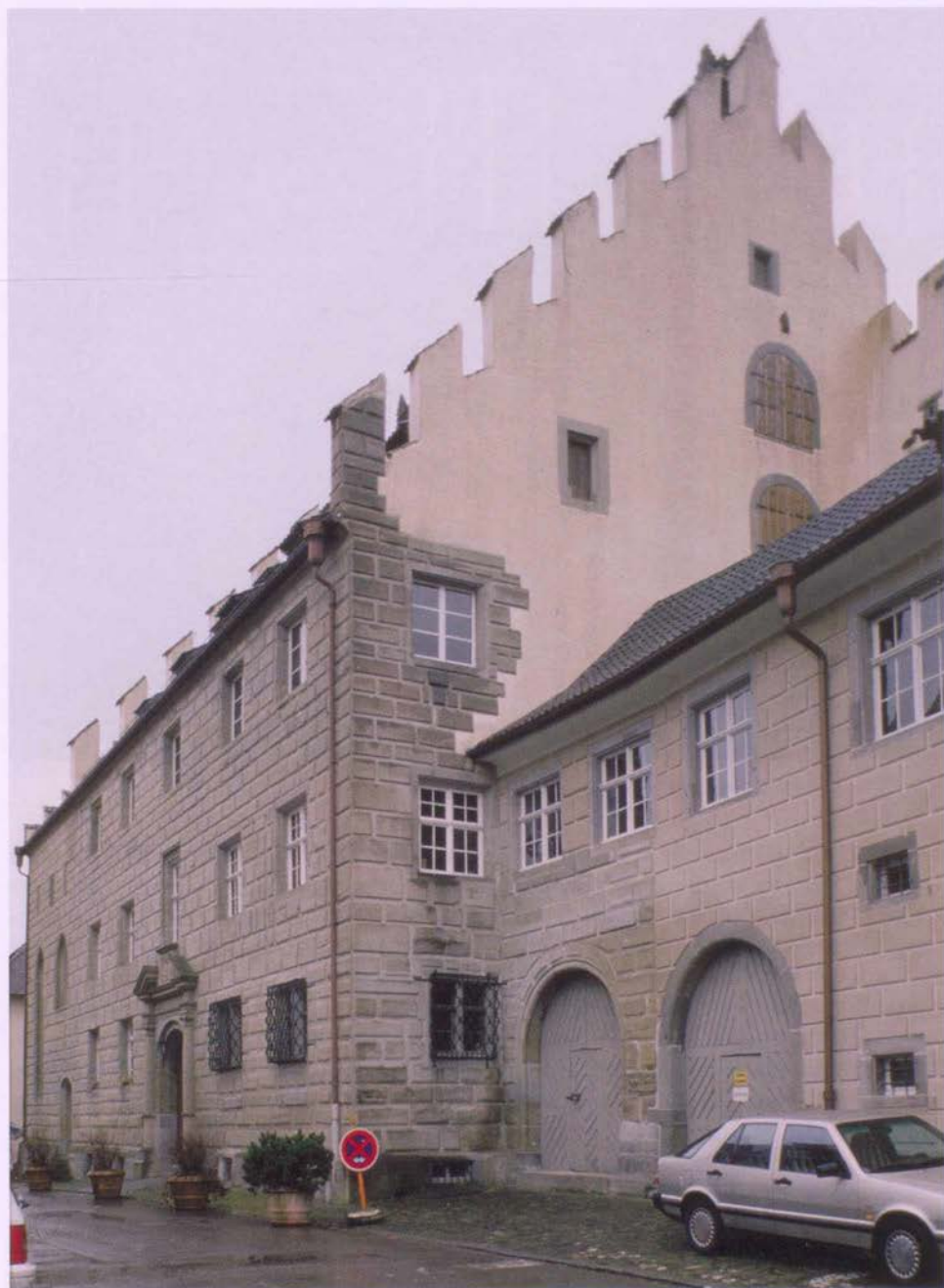
Abb. 2 Ansicht von Nordwesten
