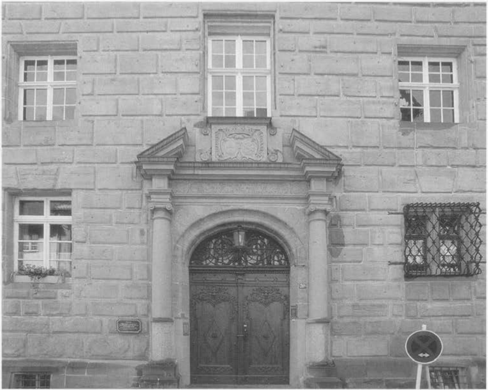
Abb. 3 Mittlere Partie der Nordfassade des Haupthauses
