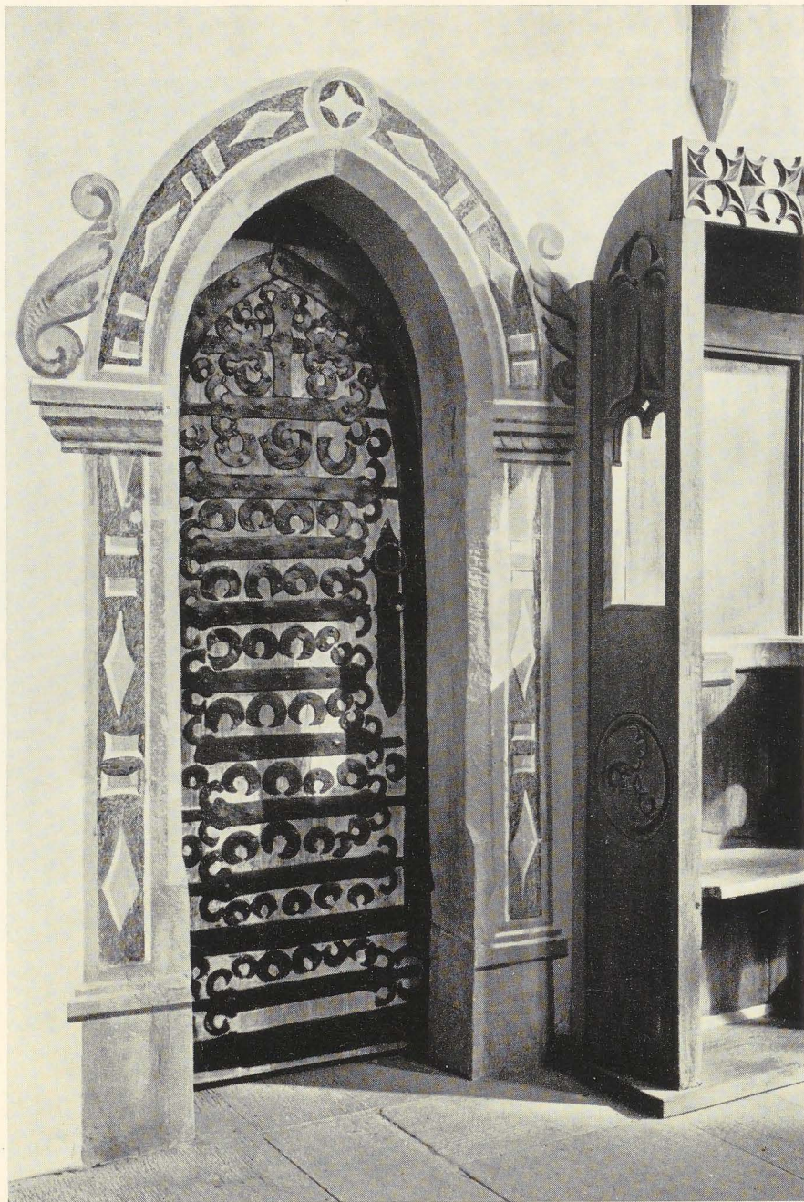
Martinskirche zu Großingersheim Tür in die alte Sakristei, mit Hufeisen beschlagen, rechts davon das alte Chorgestühl („Mönchsgestühl“)
