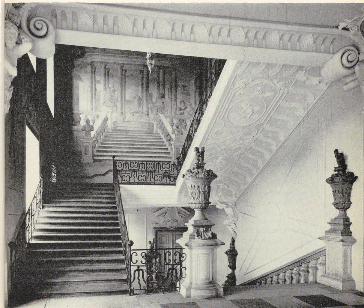
Abb. 2 Schloß Ludwigsburg, Treppenhaus im Alten Hauptbau
