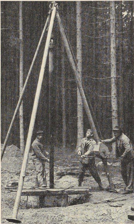
Abb. 1. Wasserbohrung im Ottmarsheimer Wald Richtung Pfahlhof.
