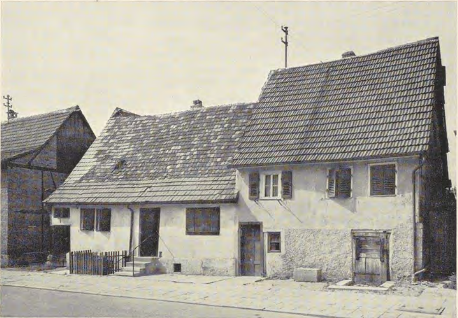
Abb. 3. Seldnerhäuser, ein- und zweistöckig
