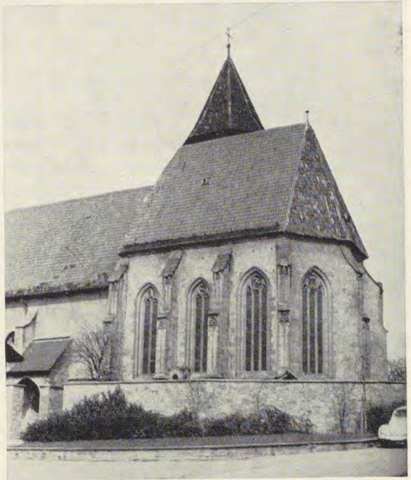
Abb. 1. Katharinenkirche Der Chor mit seinen reichornamentierten Strebepfeilern. Links das Portal mit Vorhalle, jetzt Haupteingang zur Kirche
