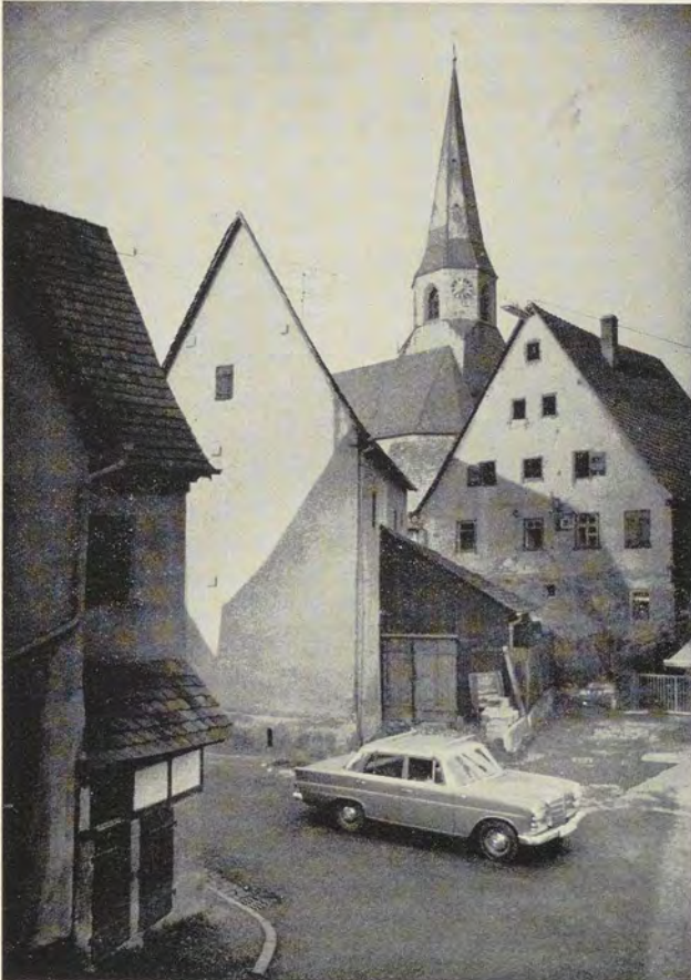
Südseite der Scheune des einstigen Gebäudekomplexes der Beghinen-Kloster
