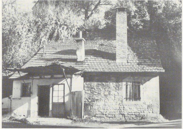
Oberes Backhaus in Benningen – 1971 abgebrochen
