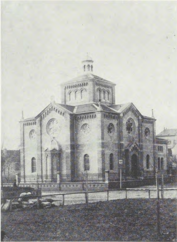
Synagoge in Ludwigsburg (zerstört 1938)
