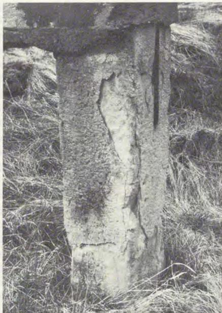
*Abb. 4: Lange wird diese Grube bei Markgröningen an der Unterriexinger Straße wohl nicht mehr stehen: Sowohl Sturz als auch Pfeiler zeigen irreparable Verwitterungsschäden infolge Salz- und Frosteinwirkung.*
