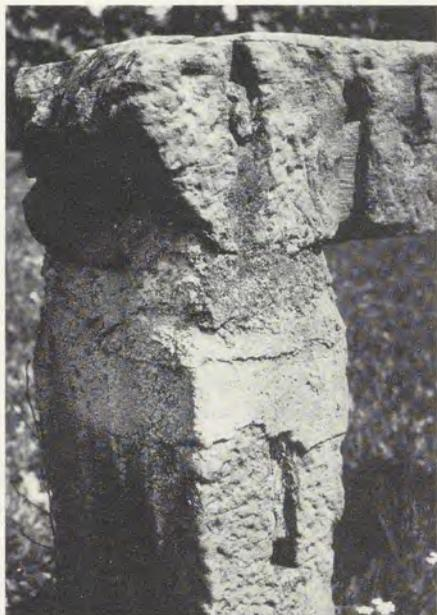
*Abb. 3: Ausgebrochene Ankerlöcher und Vertiefungen für Eisenklammerverbindungen sowie Zementierungen zeugen an dieser Grube bei Kirchheim a. N. von mehrfachem Umbau.*
