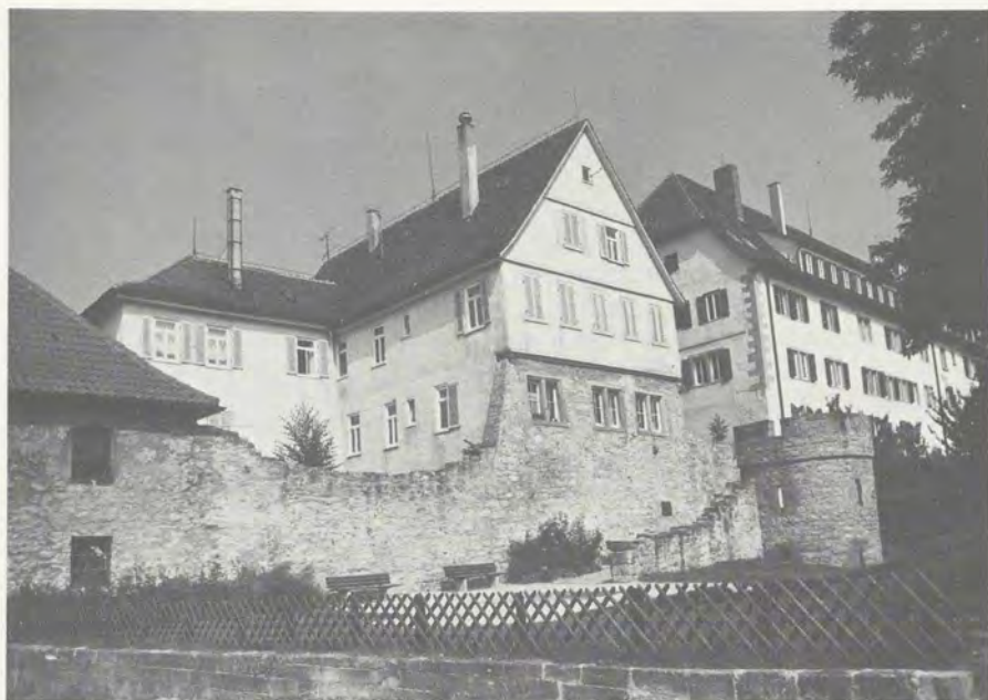
Marbach: Stadtmauer (Aufnahme: Landratsamt)
