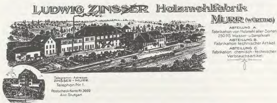
Abb. 1: Briefkopf der Firma Zinsser in Murr, gegründet 1901. Wie in vielen Firmenbriefköpfen dieser Zeit wird besonders der Eisenbahnanschluß und die Lage am Fluß zur Energiegewinnung zeichnerisch festgehalten, beides Voraussetzungen unternehmerischer Expansion.
