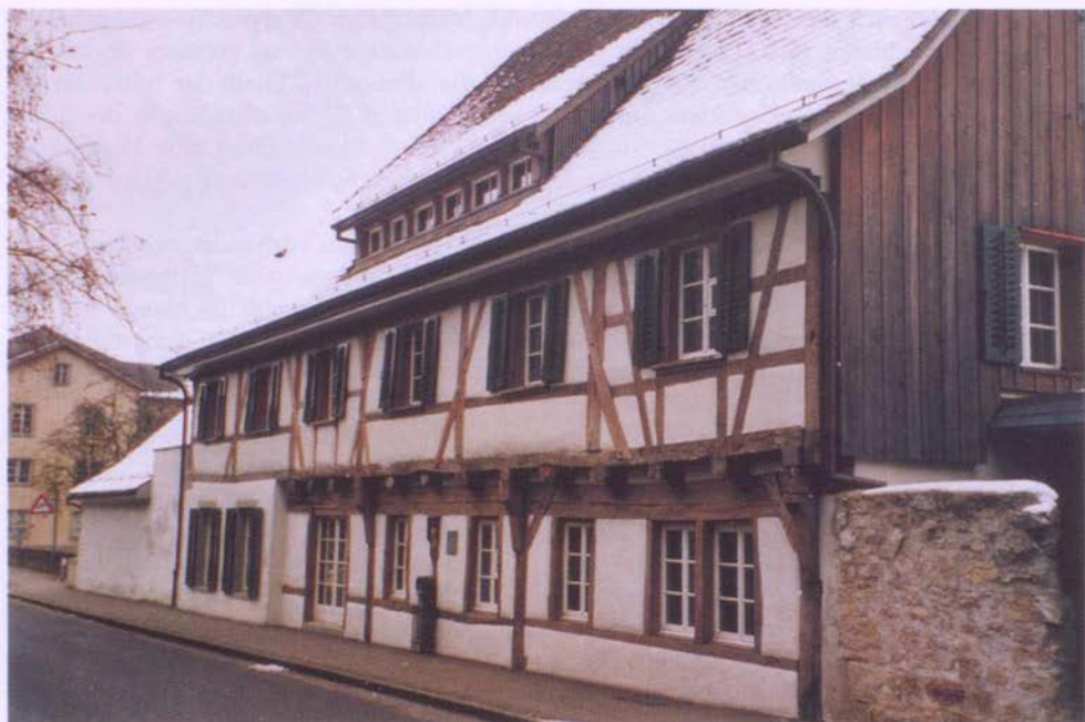
Abb. 3 Nordfassade des Sondersiechenhauses auf der Steig.
