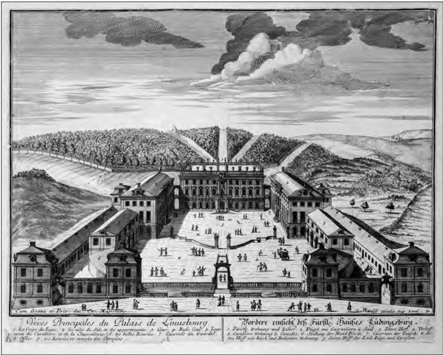
Hofansicht des Residenzschlosses. Aus einem Kupferstichwerk nach Entwürfen von Johann Friedrich Nette, 1709.
