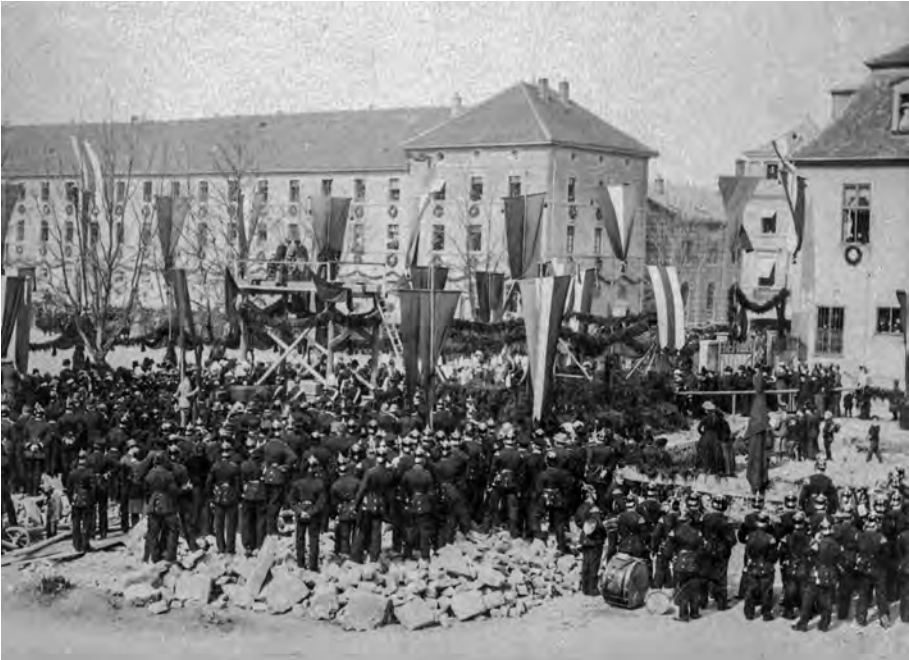
Grundsteinlegung des Offizierskasinos auf dem Arsenalplatz, 1891.
