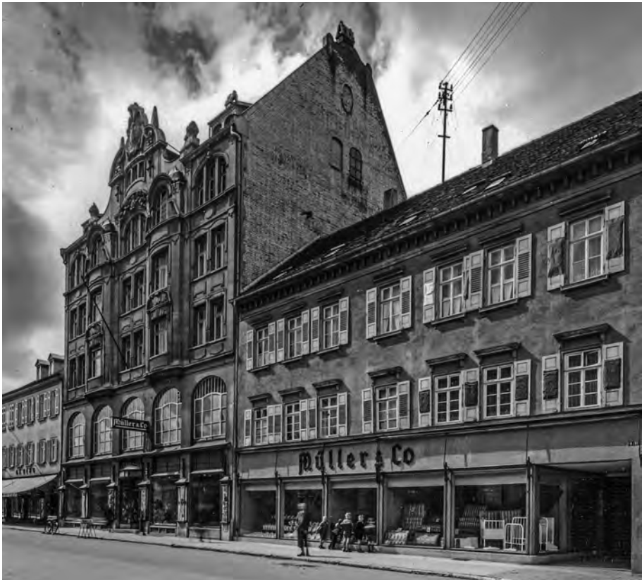
Kaufhaus Stern (Körnerstraße 9) nach der Enteignung.
