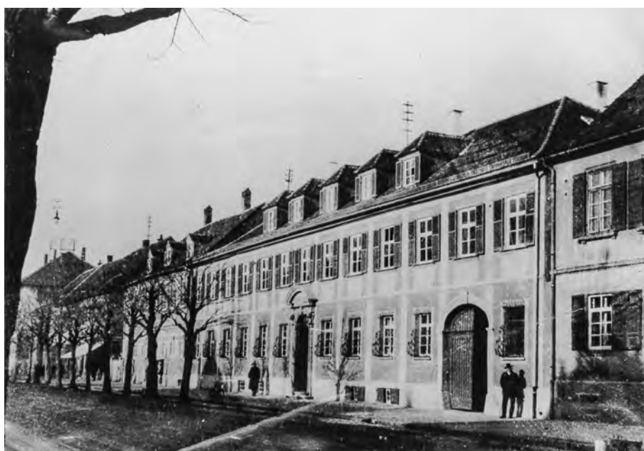
Zwei markante Gebäude in Ludwigsburg: der große Mathildenhof in der Mömpelgardstraße (oben, um 1905) und der kleine Mathildenhof in der Schorndorfer Straße (um 1930; 1944 durch Fliiegerbombe zerstört), beide Eigentum von Königin Charlotte Mathilde.
