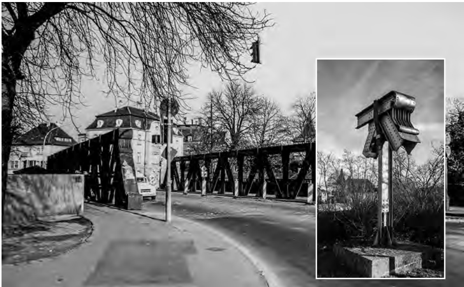
Die 1979 abgerissene Solitude-Brücke, um 1970. Die Eckkonstruktion ist als Erinnerungsstück noch erhalten geblieben.
