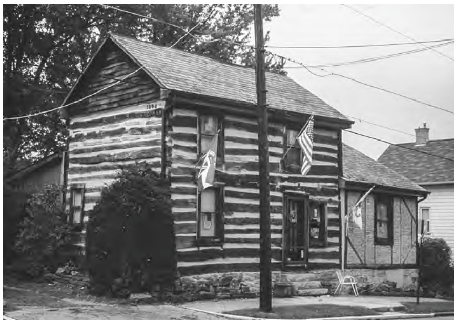
Eine der noch erhaltenen ersten Hütten in der Siedlung Harmony, Pennsylvania.
