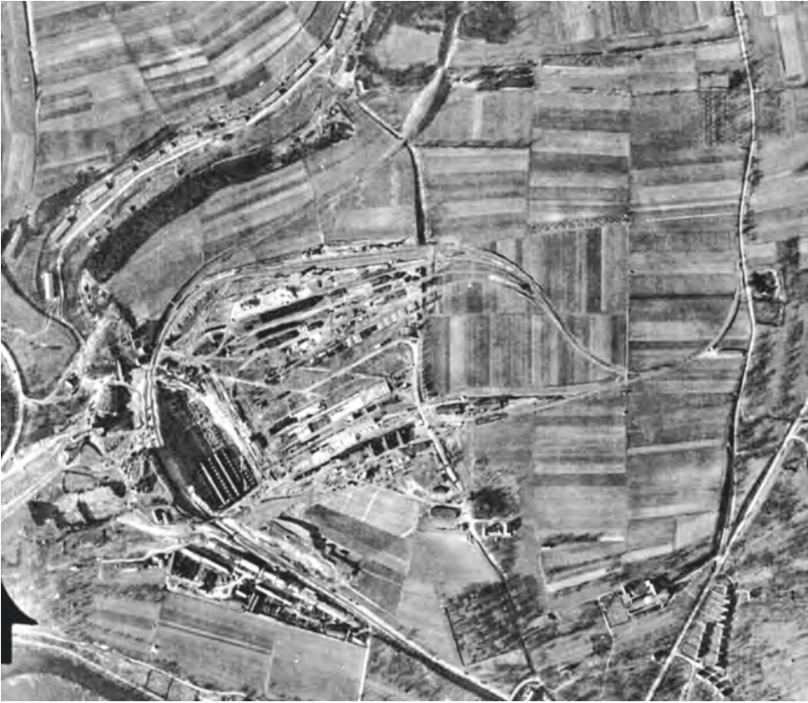
Die Baustelle »Stoffel« in einer Luftaufnahme vom 15. März 1945. Links oben sind die Baracken des Arbeits- und Konzentrationslagers zu erkennen.
