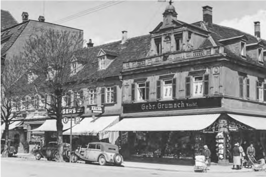
Das Kaufhaus »Gebr. Grumach Nachf.« an der Ecke Wilhelmstraße/Kirchstraße (Aufnahme um 1937).
