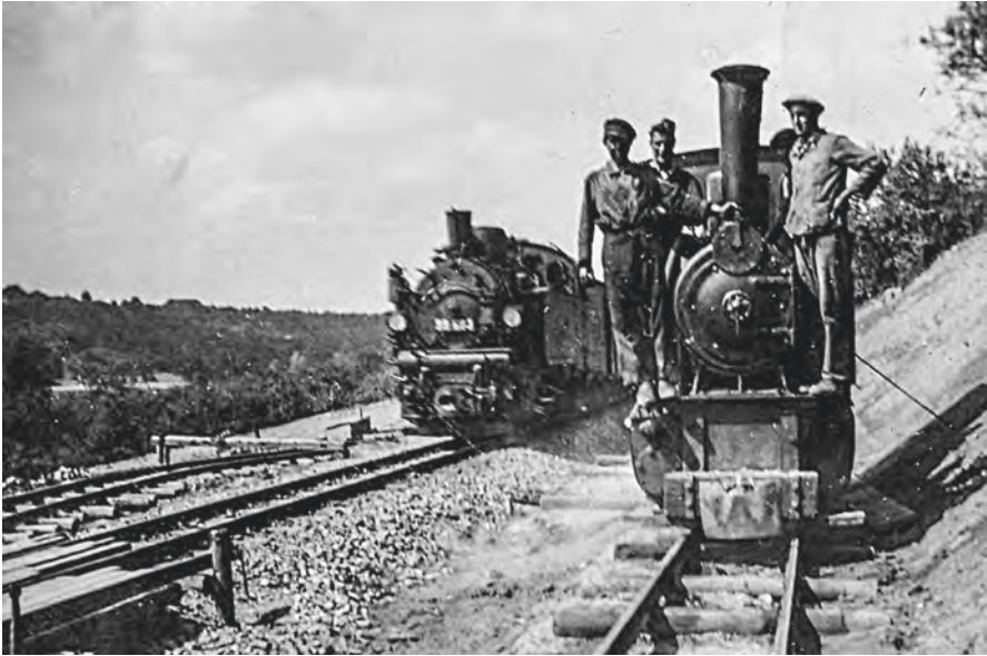
Bau des Anschlussgleises für das Kraftwerk in den Weinbergen von Marbach; links die Dampflokomotive 99 683 der Bottwarbahn auf dem Weg zum Bahnhof Marbach (1938).
