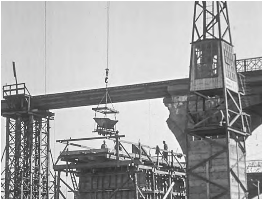
Aufbetonieren der Pfeiler des Enzviadukts in Bietigheim (1948).
