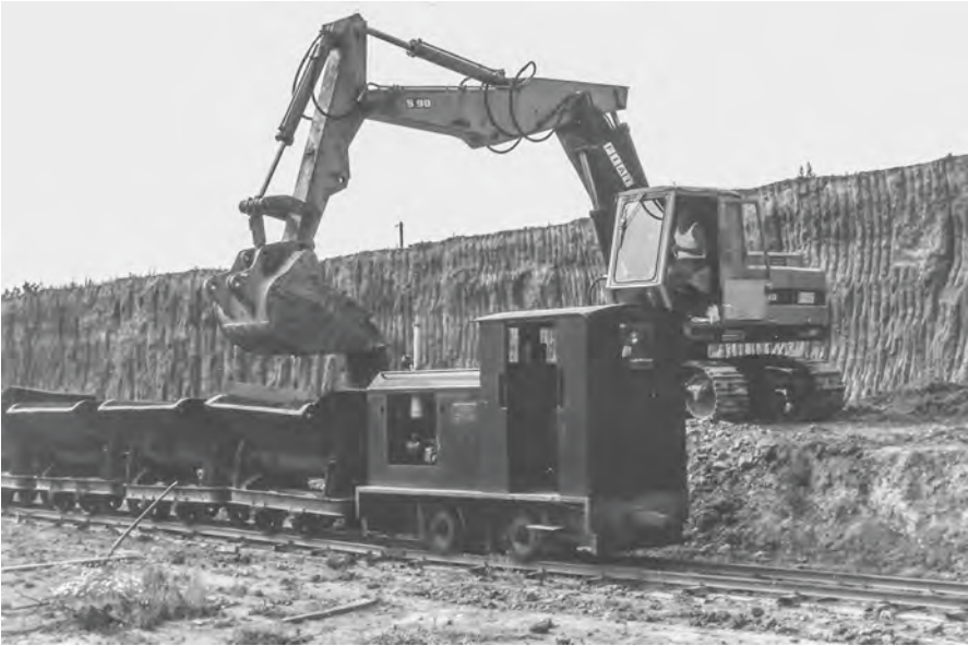
Diema-Diesellok des Typs DS 30 beim Beladen der Loren in der Grube der Ziegelwerke Ludwigsburg (23.08.1973).
