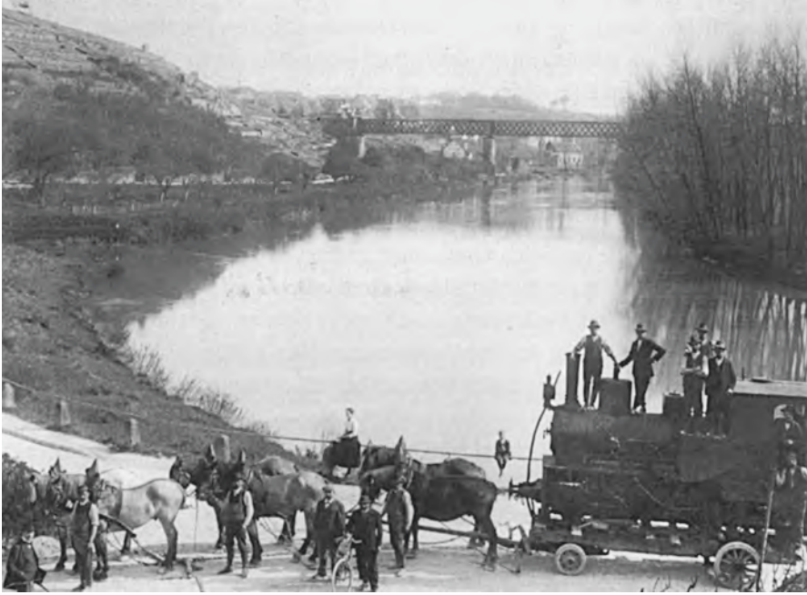
Feldbahndampflokomotive für den Kraftwerksbau in Pleidelsheim auf einem Fuhrwerk in Höhe der Murrmündung bei Marbach (1913).
