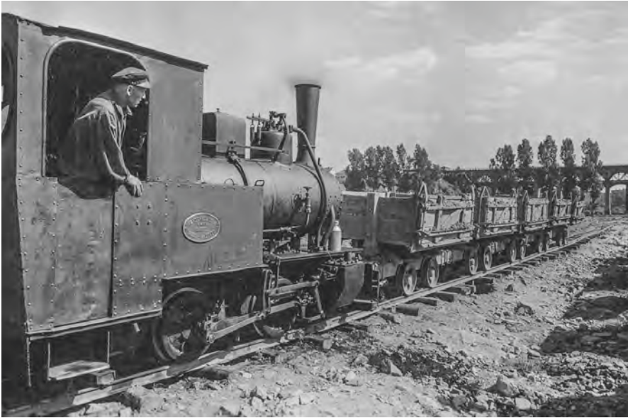
Henschel-Dampflok vom Typ »Fabian« beim Bau des Enzkraftwerks in Bietigheim (1948/49).
