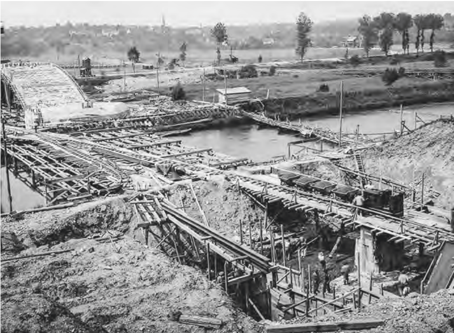
Bau der Autobahn bei Geisingen: Bremsberganlage der Firma Wölfer & Goebel (oben) und Arbeiten an der Neckarbrücke (unten; 1939).
