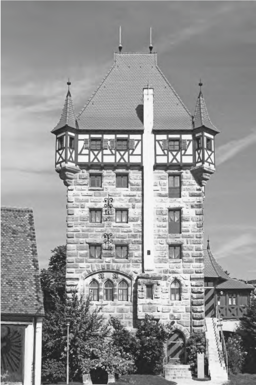
Der von Anton Schott auf Burg Abenberg erbaute Turm, im Volksmund »Schottenturm« genannt.
