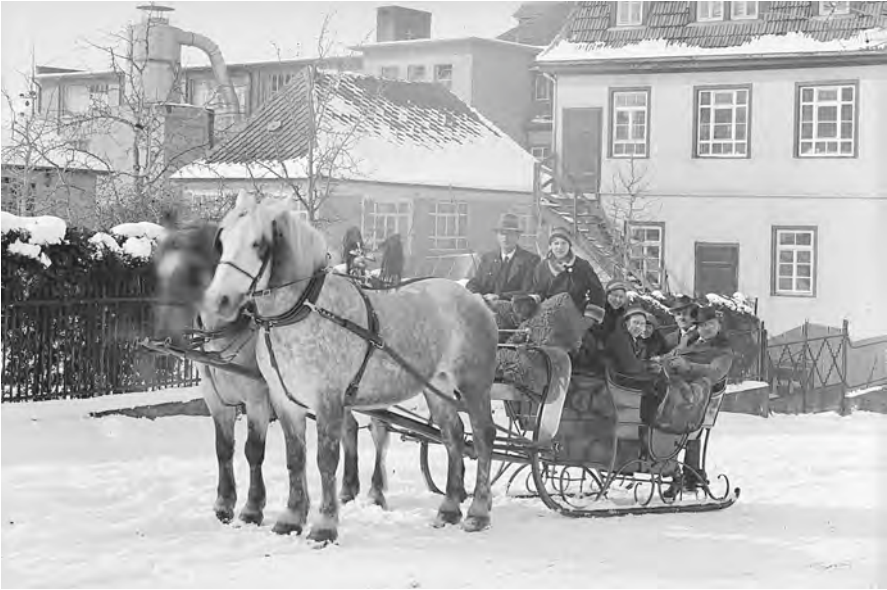
Die Familie Feil im familieneigenen Schlitten vor dem heute noch existierenden Verwaltungsgebäude in der Ziegelstraße (um 1938).
