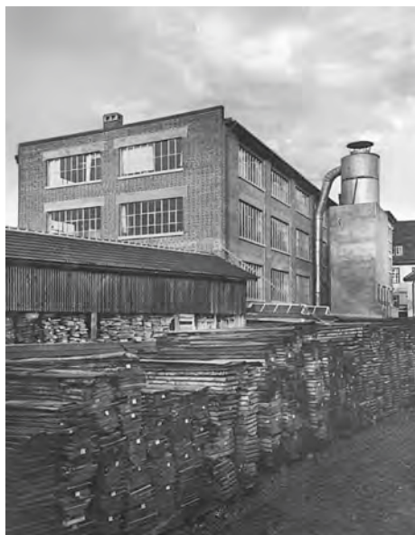
Blick auf den Holzlagerplatz hinter dem Erweiterungsbau (1938).
