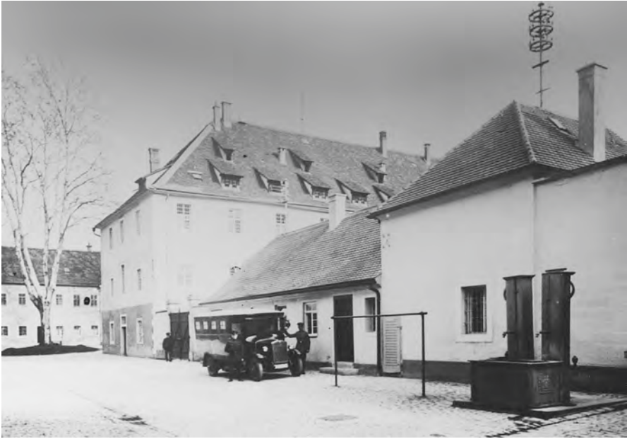
Innenhof des Zuchthauses mit doppeltem Pumpbrunnen (um 1930).
