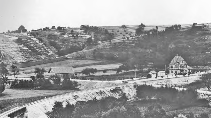
Blick auf den weit außerhalb des Ortes gelegenen Bahnhof Schwieberdingen kurz nach der Fertigstellung der Strohgäubahn im Jahr 1906.
