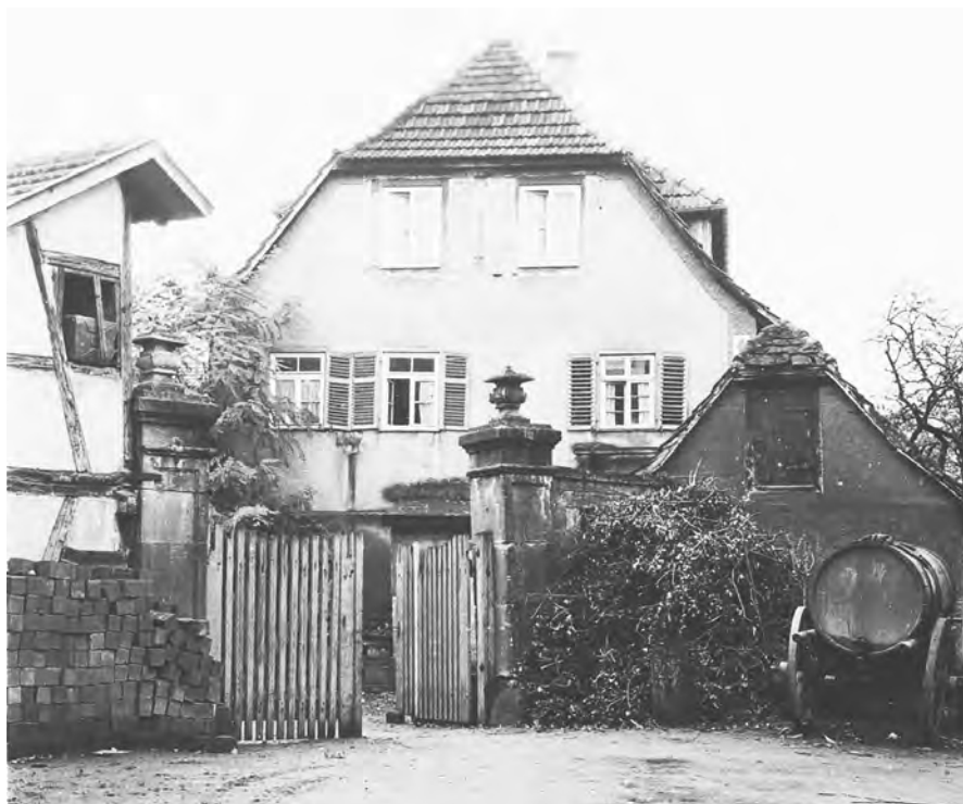
Das von Gabriel Dreifuß 1802 renovierte ehemalige Pfarrhaus.
