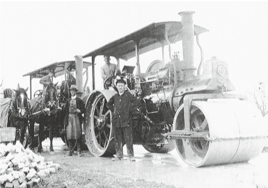
Straßenbau bei Schwieberdingen, 1928.
