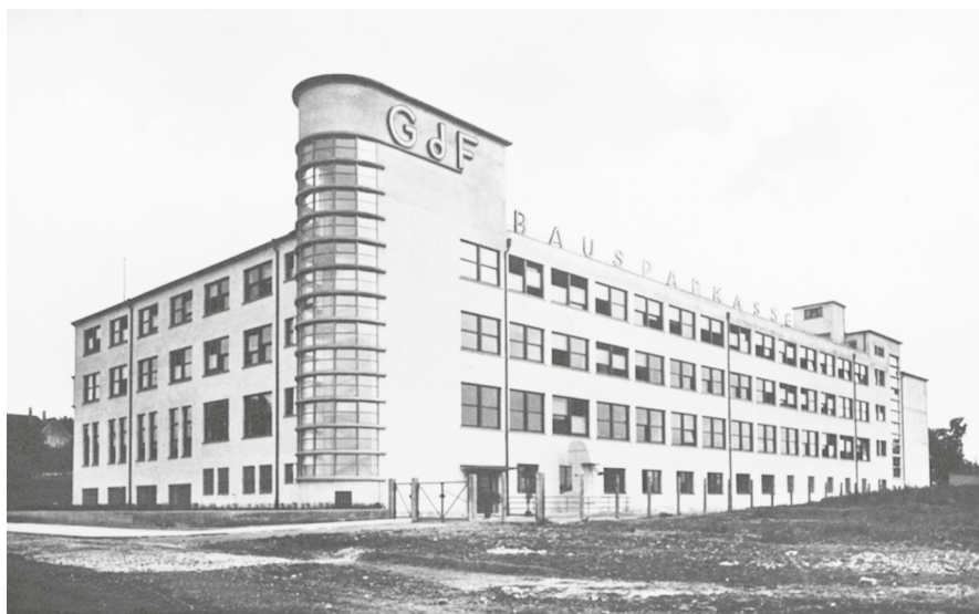
Anfang November 1928 verlegte die Bausparkasse »Gemeinschaft der Freunde Wüstenrot« Teile ihres Betriebs von Wüstenrot nach Ludwigsburg. Im April 1930 bezog sie ihr neues Verwaltungsgebäude an der Hohenzollernstraße.
