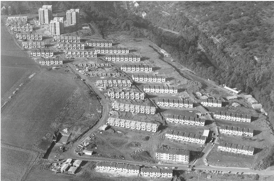
Stand der Bauarbeiten am 24. Oktober 1958.
