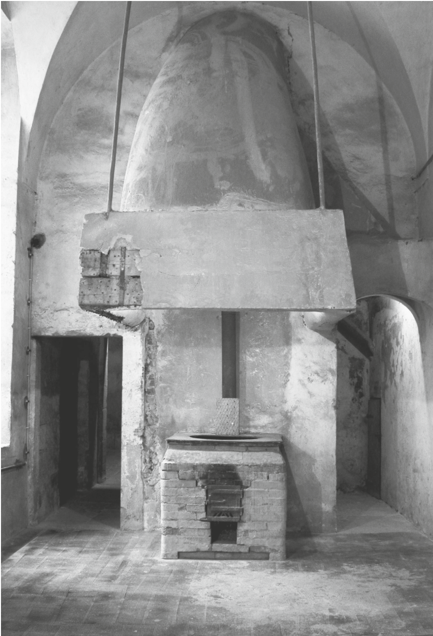
Ehemalige Waschküche im Erdgeschoss des Neuen Corps de logis. Im Herd war ein eiserner Kessel zum Kochen der Wäsche eingelassen, im Fenster befindet sich ein Spülstein mit Ausguss in den Lichthof.
