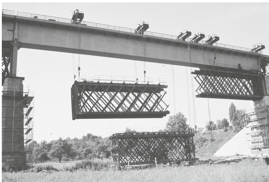
Demontage des alten Neckarviadukts.
