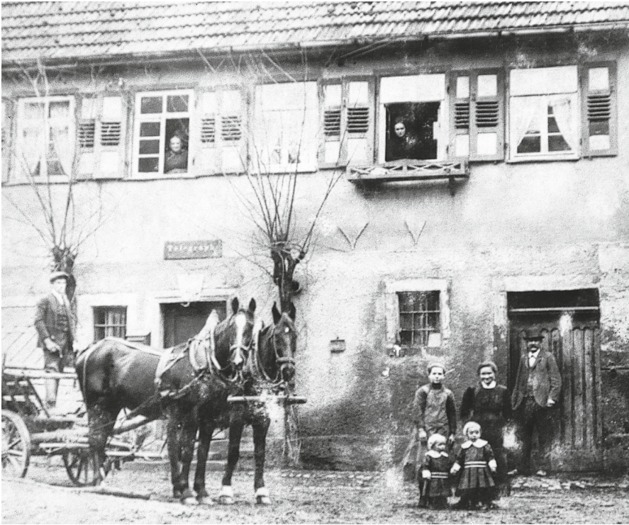
Noch um 1900, als dieses Foto der Familie Rath entstand, waren die Siegelhäuser Einwohner stolze und wohlhabende Bauern.
