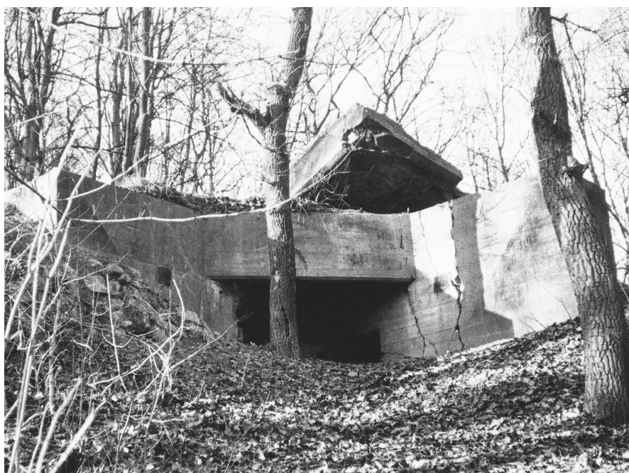
Ruine des im Bataillonsabschnitt G (Glems) unmittelbar an der Einmündung des Leudelsbachs in die Enz gelegenen MG-Schartenstandes G 1 (Aufnahme von 1981).
