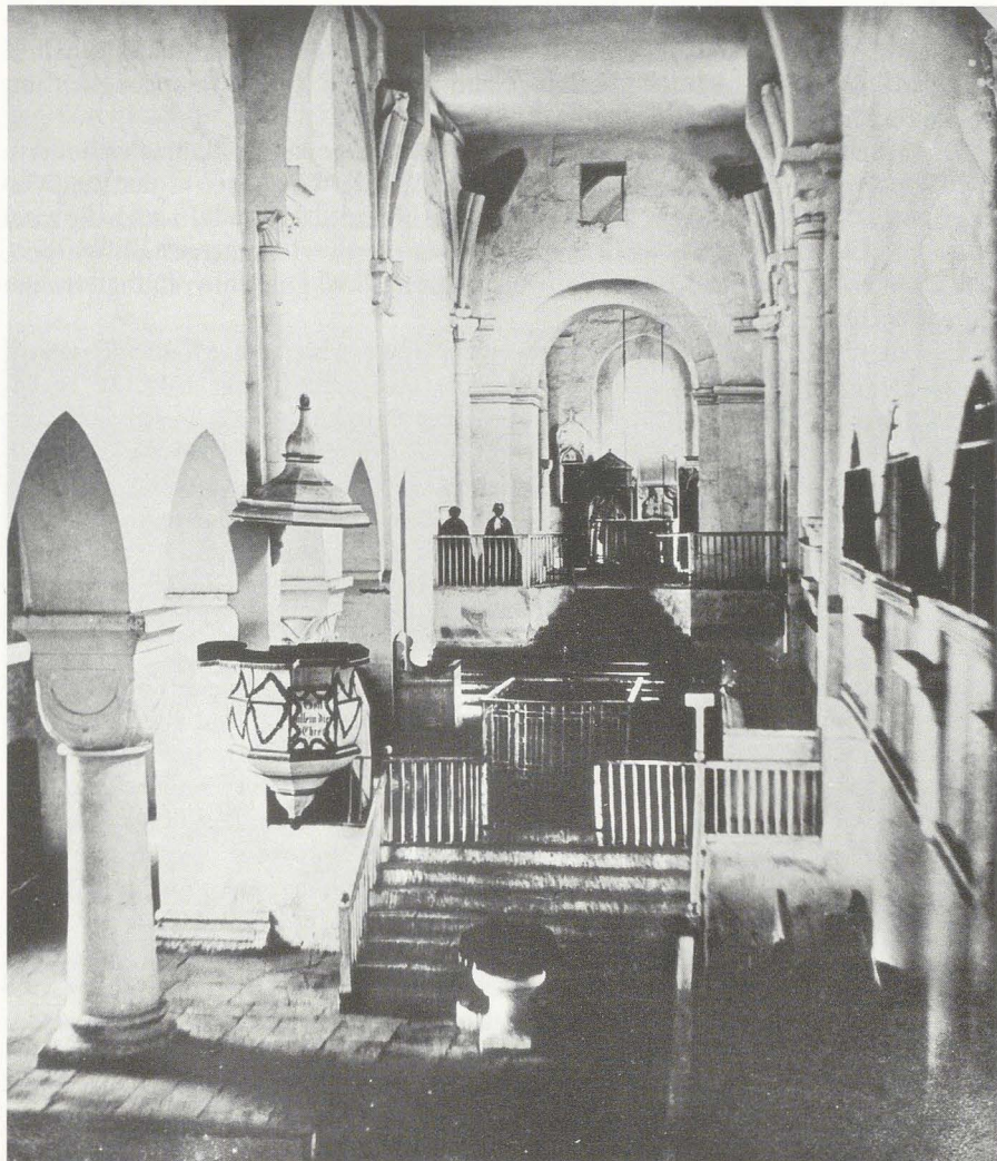
Das Kircheninnere vor der Renovierung, 1866. Deutlich ist die Staffelung Vorchor/Turmchor zu erkennen, auch die Behelfsdecke über den Rippenresten. Noch sind rechts die Empore, links die alte Kanzel und in der Mitte der romanische Taufstein in der Kirche.
