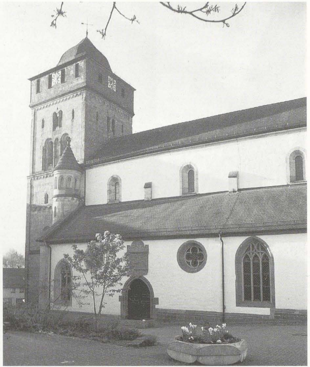
Die Nordseite der Stiftskirche mit dem 1888/91 errichteten runden Treppenturm.
