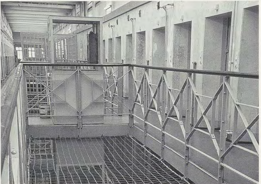
Abb. 49: Mittelhalle des Schlafzellenbaus. Aufnahme 1988.
