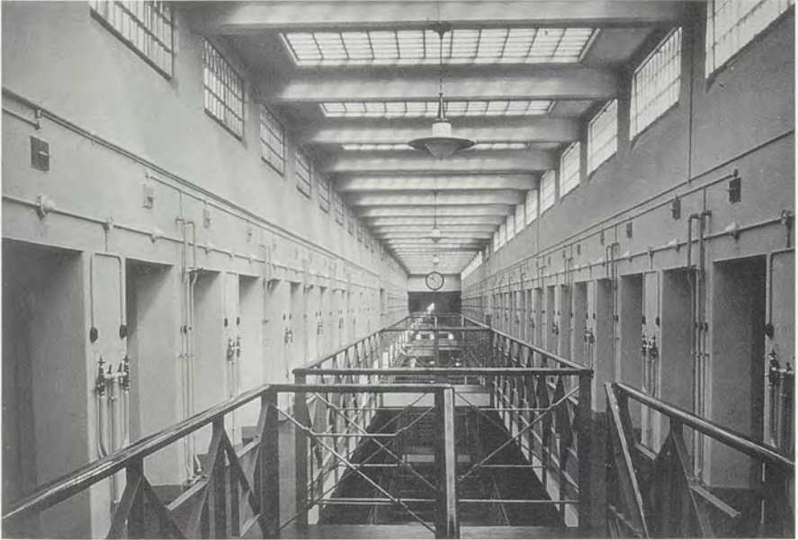
Abb. 28: Mittelhalle des Schlafzellenbaus. Aufnahme um 1930.
