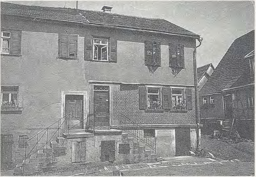
Dieses Gebäude in der Haller Straße 3 in Wüstenrot erwarb Pauline Kropp am 15. Januar 1920. Im Februar 1924 nahm im ersten Stock die Bausparkasse ihre Arbeit auf.
