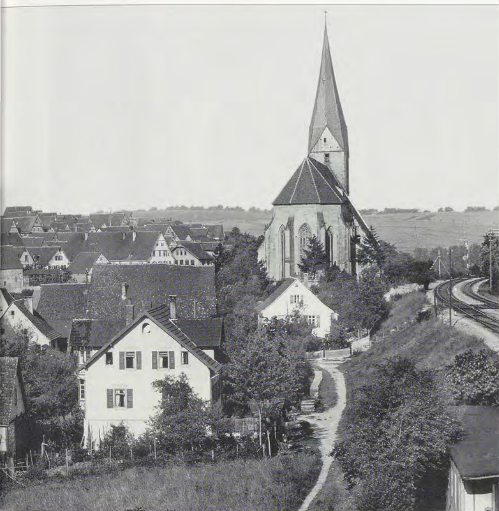
unmittelbar neben der Kirche verlaufenden Bahndamm.
