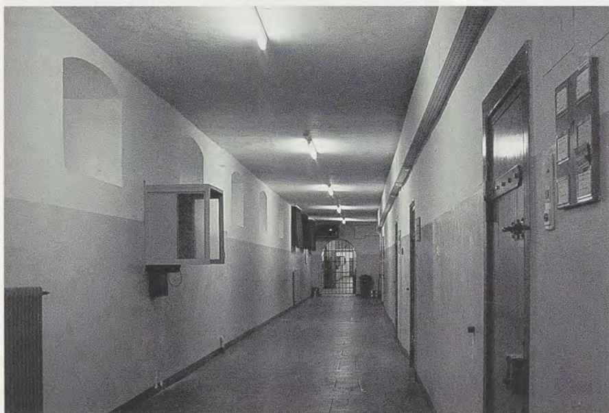
Abb. 45: Flur Bau 3. Aufnahme 1988.
