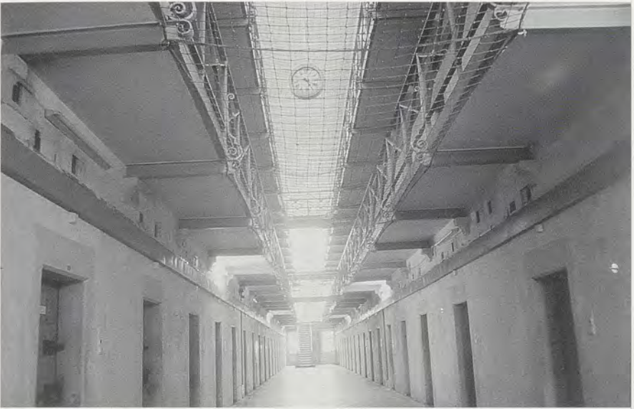
Abb. 33: Erdgeschoß des Alten Zellenbaus. Aufnahme 1985.
