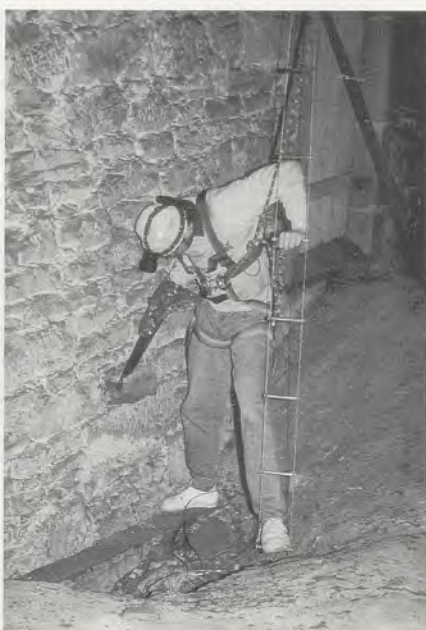
Absägen eines Balkenrests im nördlichen Dachstuhlbereich an der Außenwand der Oberlichtfenster zur dendrochronologischen Untersuchung.
