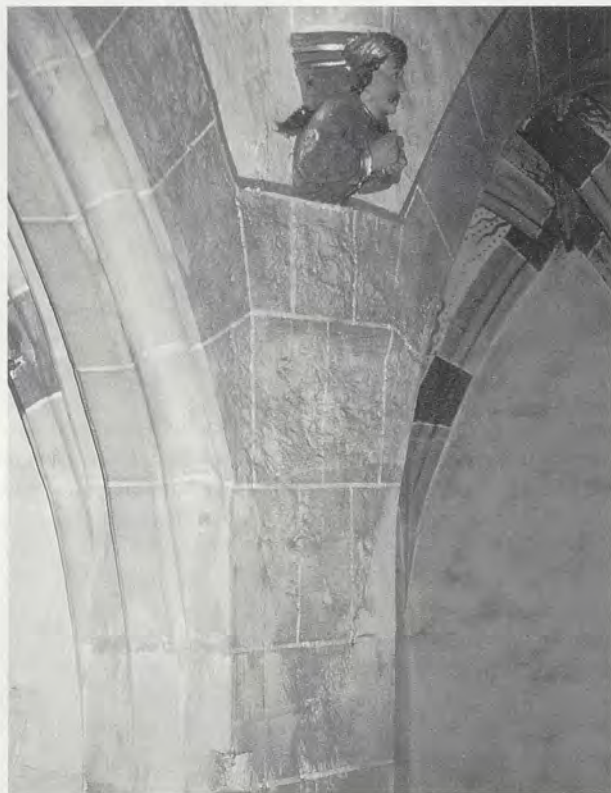
Sichtbare Spuren der abgemeiselten Gewölbeansätze im nördlichen Seitenschiff.
