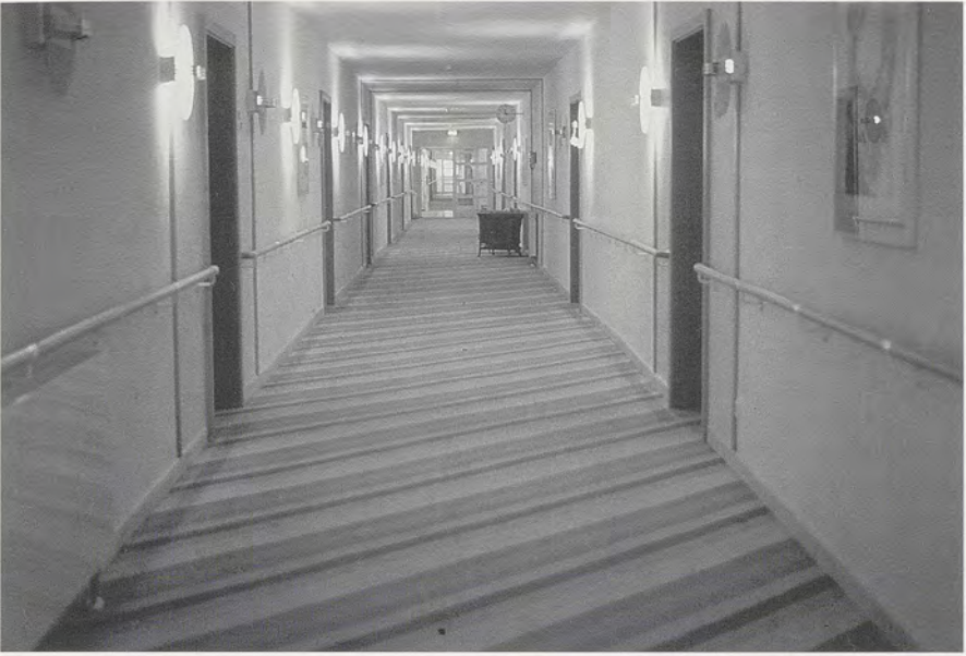
Abb. 46: Flur Westflügel (ehem. Bau 3) des ELISA-Seniorenstifts. Aufnahme 1996.
