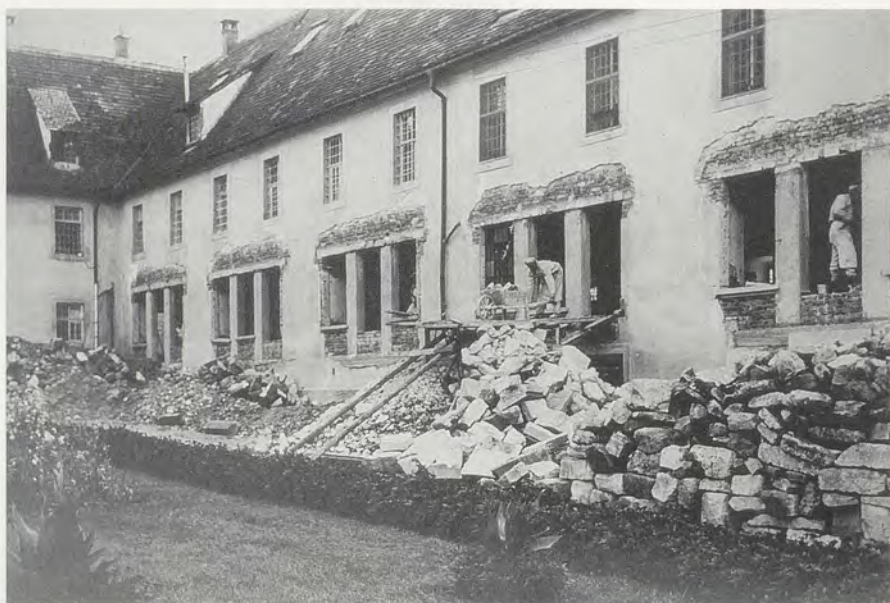
Abb. 26: Umbau von Bau 2. Aufnahme 20.8.1932.
