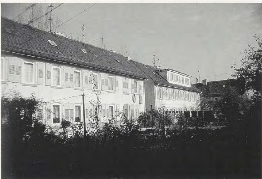
Abb. 38: Die Beamtenwohnhäuser (»Dörfle«). Aufnahme 1996.
