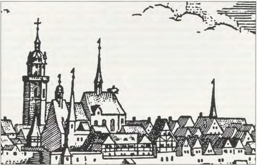
Abb. 3: Ansicht Bietigheims von Merian.
