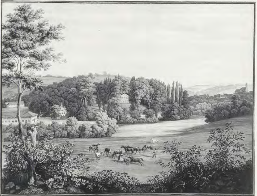
Scharnhausen. Klassizistisches Lustschloß, auf Veranlassung Herzog Carl Eugens ab 1783 erbaut, in großem Park mit weidenden Pferden des Gestüts. Rechts Dorf und Kirche. Im Hintergrund die Alb. Aquarell aus dem König-Wilhelm-Album 1841.
