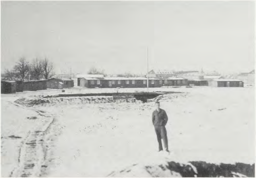
Abb. 8: Stellung Kornwestheim: Unterkunftsbaracken mit Kantinenbaracke; Vordergrund: eingegrabene Mannschaftsbaracke, Hintergrund: Ludendorff-Kaserne
