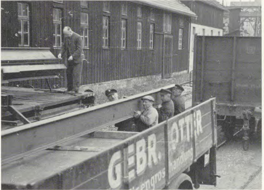
Eisenlagerplatz Franzosenstraße (heute: Martin-Luther-Straße, um 1935)
