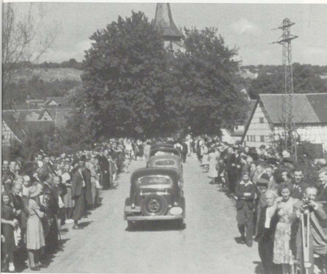
Einweihung der Notbrücke über den Neckar zwischen Ludwigsburg und Neckarweihingen am 1. Mai 1946
