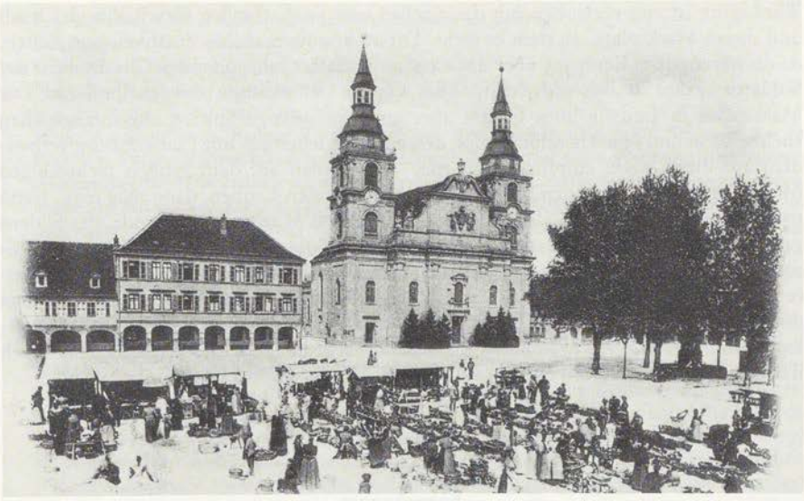
Bild 8: Das Gebäude Marktplatz 11 als Schulhaus nach der im Jahre 1882 erfolgten Aufstockung, um 1895. (Stadtarchiv Ludwigsburg)
