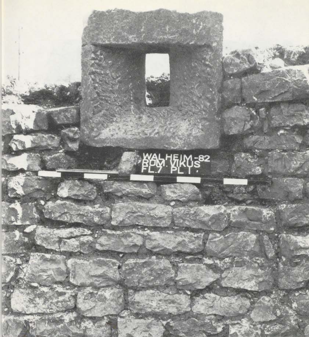
Abb. 32 Walheim a. N. Keller im Gebäude Nr. 4 mit Kellerfenster in situ.
