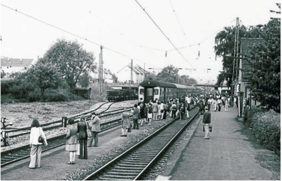
Wartende Reisende am Bahnhof Ditzingen vor dem Ausbau für die S-Bahn.
