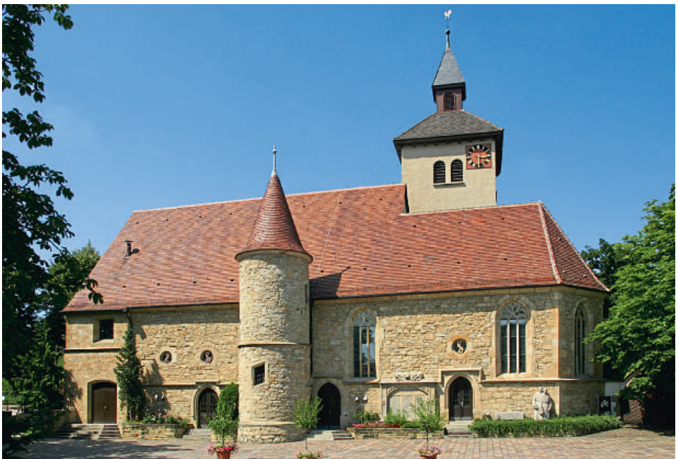
Die evangelische Michaelskirche wurde Mitte des 16. Jahrhunderts erbaut und erhielt um 1600 als Anbau den charakteristischen Schneckenturm im Stil der Frührenaissance.
