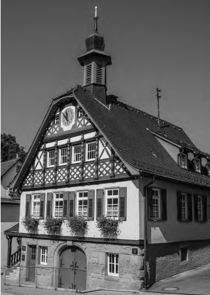
Das alte Rathaus an der Dorfstraße mit Zierfachwerk von 1914.
