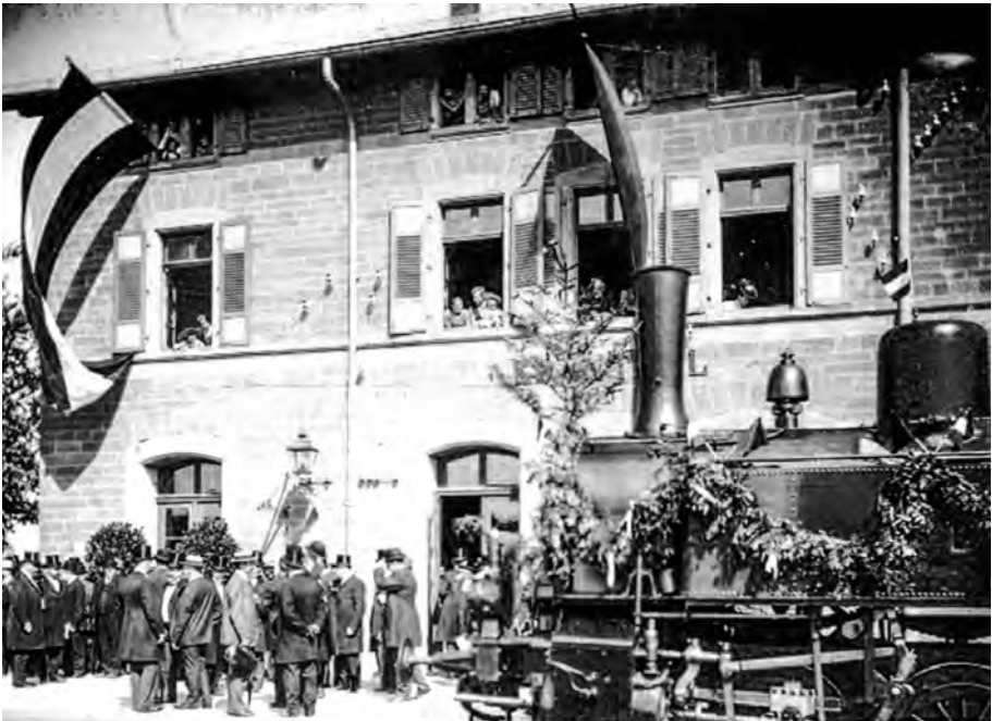
Eröffnungsfeierlichkeiten am Bahnhof Korntal am Vormittag des 13. August 1906. Rechts im Bild eine der beiden bei Humboldt in Köln gebauten 4-achsigen Tenderlokomotiven.
