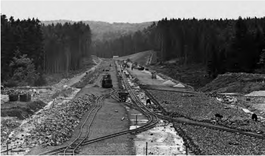
Für den Bau der Autobahn von Stuttgart nach Mannheim wurden am Bahnhof Auenstein Baustoffe und Maschinen von der Bottwartalbahn auf Feldbahnen zum Weitertransport auf die Baustelle umgeschlagen. Im Bild: Baustelle bei Untergruppenbach, 7. Oktober 1935.
