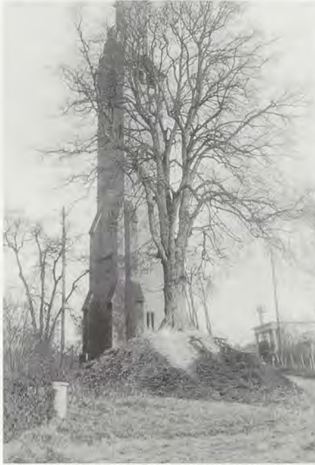
Ansicht von Süden, 1953. Im Hintergrund rechts das Männerheim Salon, im Vordergrund die »widerborstige« Linde.
