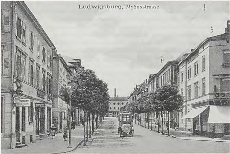
Oberleitungsbahn in der Myliusstraße.
