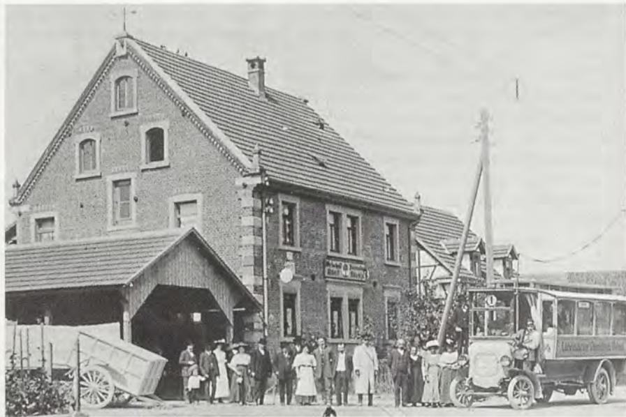
Die Oberleitungsbahn an der Haltestelle »Friedenslinde« in Neckargröningen. Links der Postkarren vor dem Schuppen, in dem über Nacht einer der Motorwagen eingestellt wurde.
