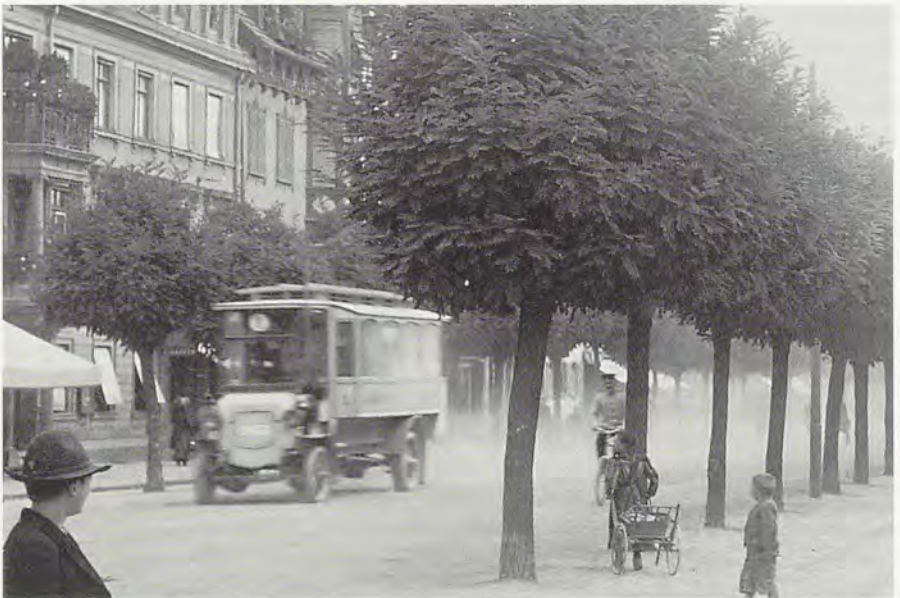
Oberleitungsbahn in der Wilhelmstraße. Die Staubentwicklung auf den geschotterten Straßen war ein ständiges Ärgernis.
