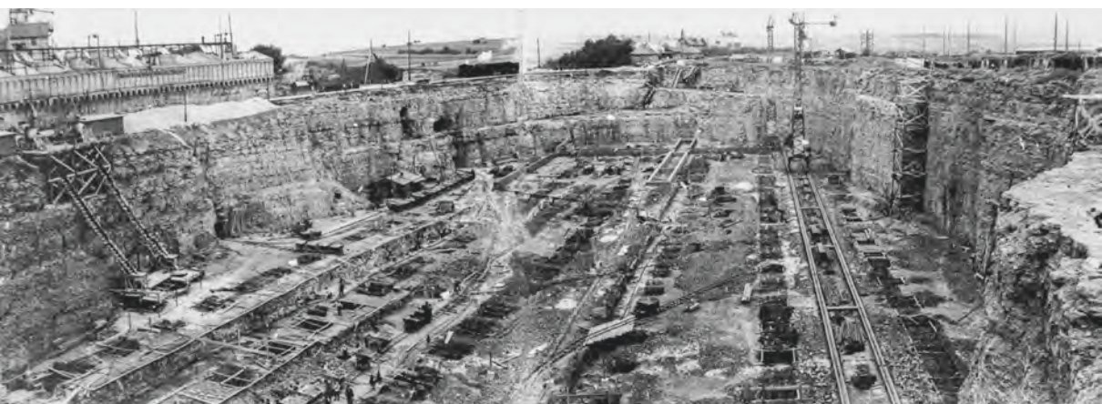
Blick auf die Baustelle, 11. August 1944.
