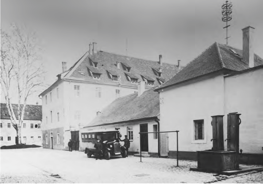
Innenhof des Zuchthauses mit doppeltem Pumpbrunnen (um 1930).
