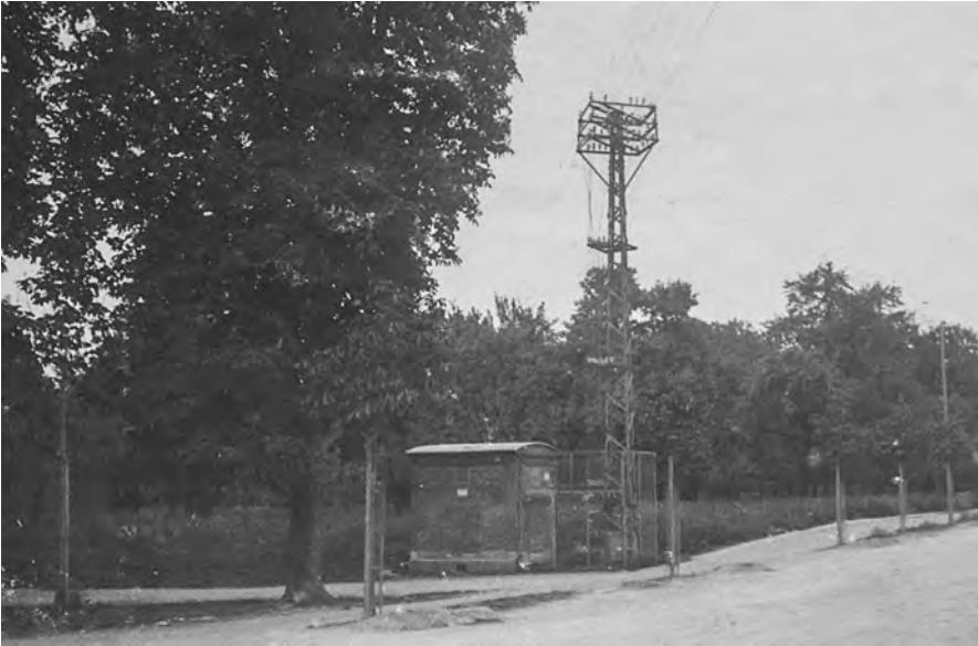
Trafostation an der Bärenwiese (Ecke Stuttgarter Straße/Friedrich-Ebert-Straße) mit Stromverteilungsmast, um 1905.
