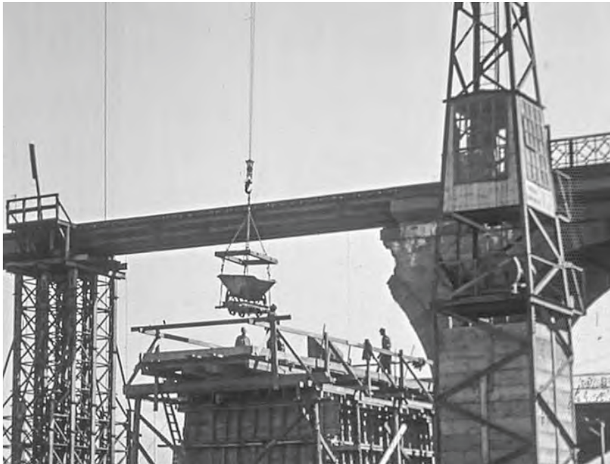
Aufbetonieren der Pfeiler des Enzviadukts in Bietigheim (1948).
